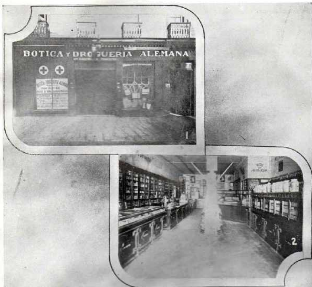
1. Fachada de la Farmacia.—2. Vista interior de la misma
