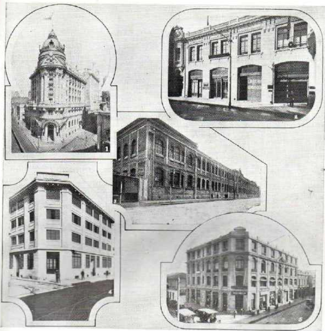
Dyckerhoff y Widmann, Sociedad Anónima. Algunas obras de importancia ejecutadas en Santiago. 1.—Edificio de la Compañía de Seguros «La Mundial» 2.—Edificio del «Círculo Helvético» 3.—Escuela de los Padres Franceses. 4.—Edificio de la Caja de Crédito Popular. 5.—Edificio Bandera esq. Santo Domingo.
