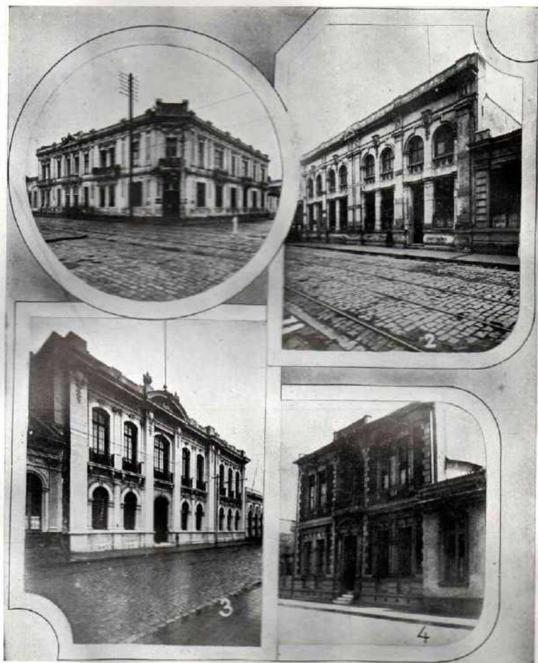
Algunas obras ejecutadas por el arquitecto señor Roberto Haschke en Concepción.—1. Edificio ocupado por la casa comercial J. Schneider.—2. Edificio ocupado por la casa Weber & Esquerre Bank.—3. Edificio del Club Concepción.—4. Casa habitación del señor Haschke en la calle San Martín 268. Concepción.
