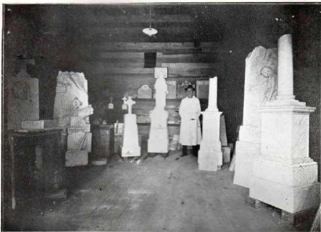
El señor Pablo Herold en su taller con algunas obras de arte ejecutadas por él.
