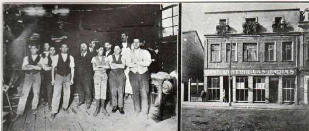
1. El señor Rodríguez Bachmann y sus operarios.—2. Entrada a la Hojalatería y vista del frente de la casa de propiedad del señor don Carlos Rodríguez Bachmann, en la calle Eleuterio Ramírez.
