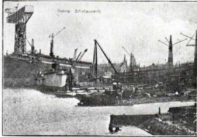
Danzig, un astillero donde se construyen naves.
