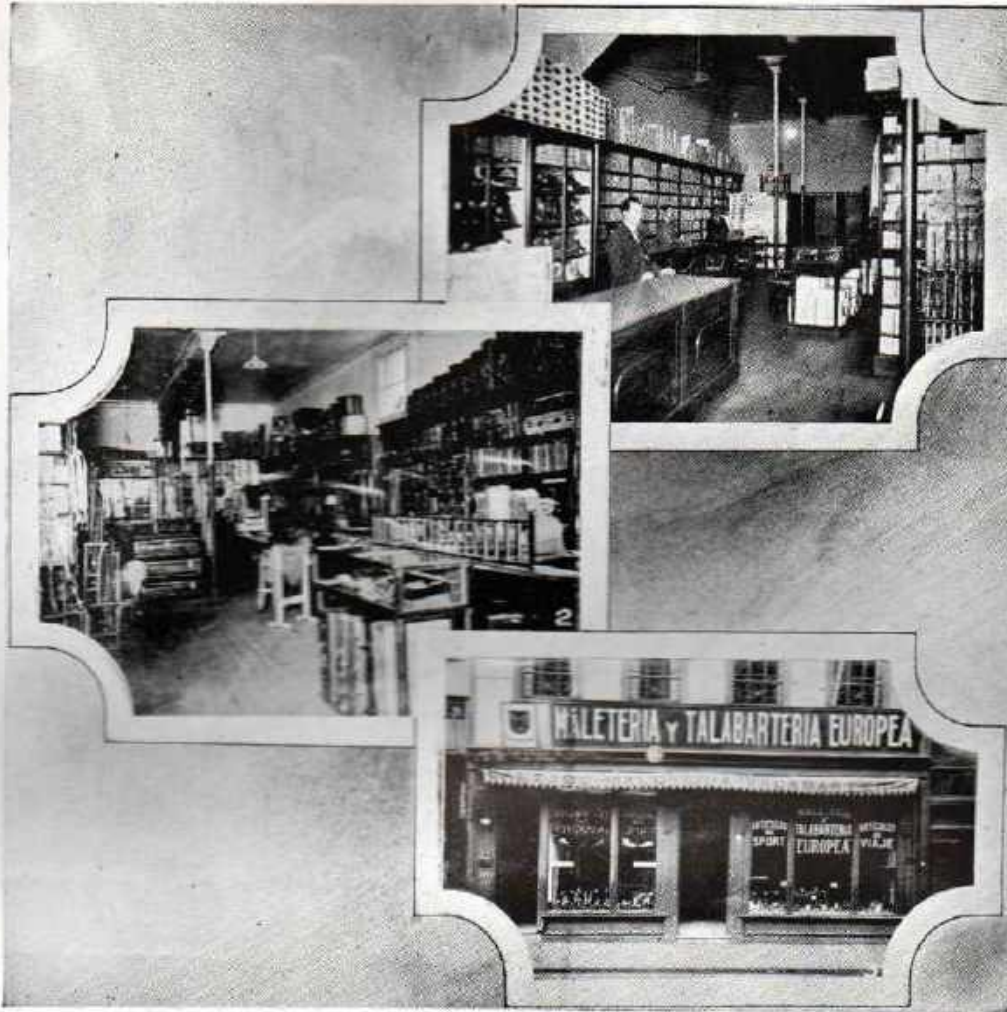
1. Sección Zapatería.—2. Sección Maletaría y Talabartería.—3. Fachada de la casa Schäfer y Cía.
