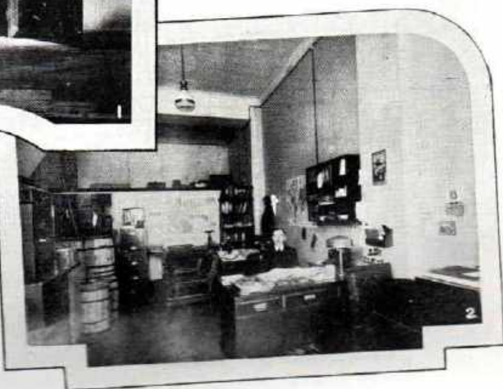
Fachada e interior del negocio del señor R. P. Hänel, que posee en Bandera 578
