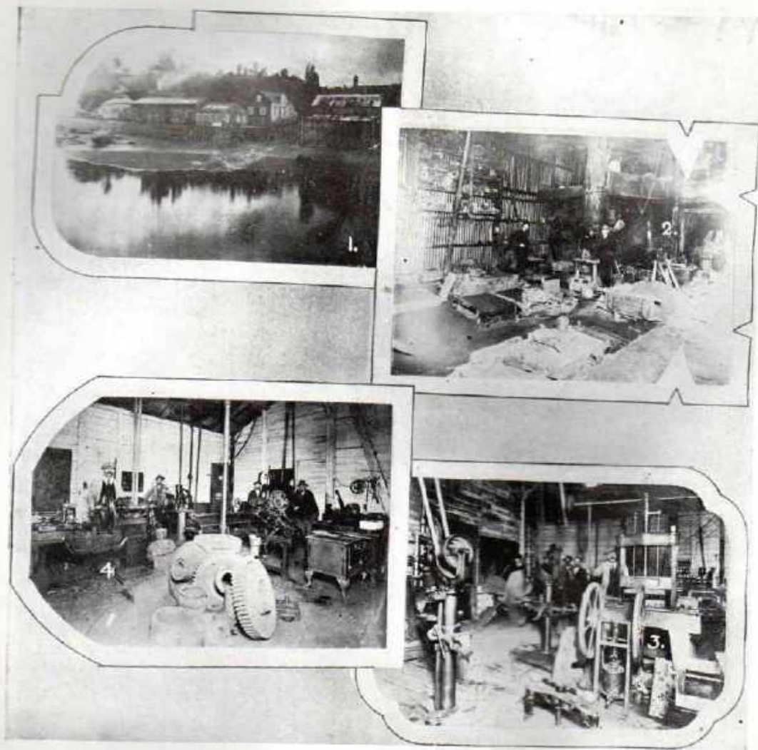
1. Vista general de la maestranza del señor A. W. Cernoch en Puerto Montt.—2. Sección fundición.—3. Balancines y tornos para agujerear.—4. Sección torneado.
